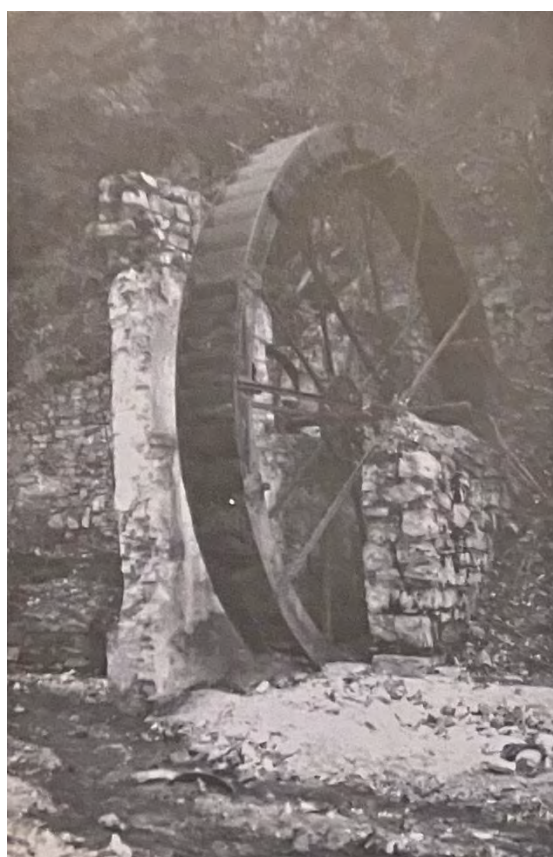
Figura 18. Fotografia dei resti della grande ruota e di porzioni di muri in pietra appartenenti ai fabbricati del “mulino a monte” situato nella zona di Premiano, nell’alveo del Gobbia ( Lungo il Gobbia alla ricerca della nostra storia , 2002).
