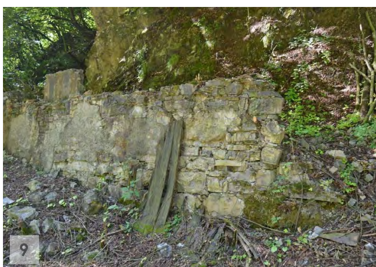
Figura 29. Ripresa 9 di porzioni di muri in pietra appartenenti ai fabbricati del “mulino a monte”
