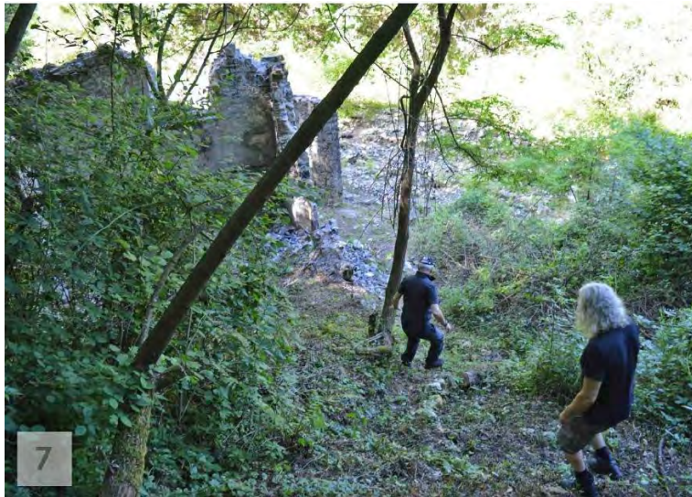
Figura 34. Ripresa 7 del “mulino a valle” dal sentiero di accesso
