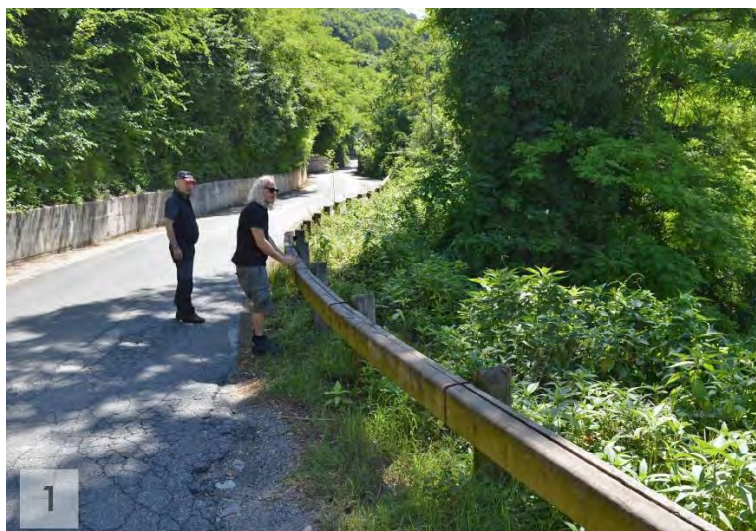
Figura 24. Ripresa 1 dell'ingresso al "mulino a monte" da via Madonnina, Premiano, Lumezzane
