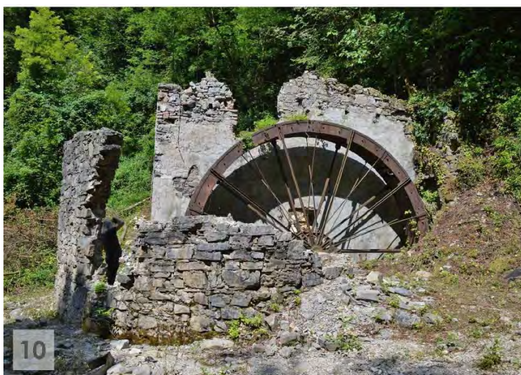
Figura 36. Ripresa 10 della ruota in ferro del “mulino a valle”
